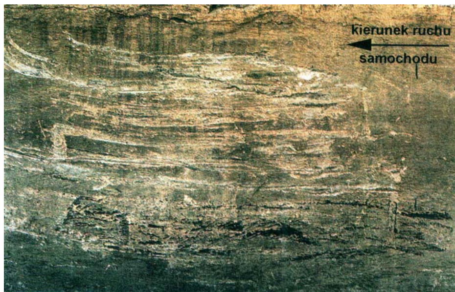
Fot. 8. Ślady na tynku muru budynku od uderzenia samochodem osobowym.
