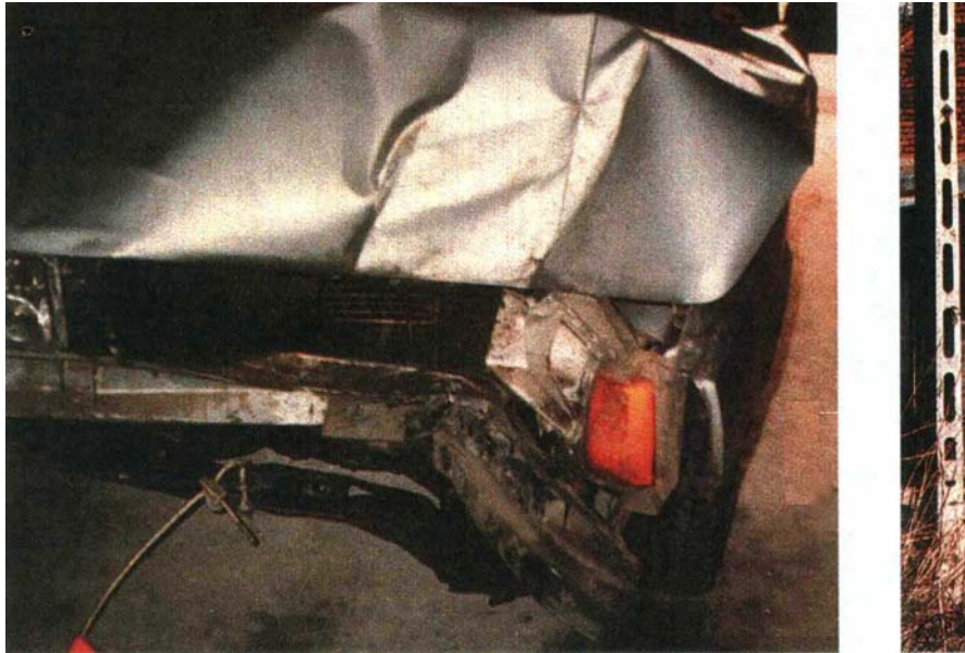
Fot. 4. Uszkodzeniu słupa i samochodu, który w ten słup uderzył.
